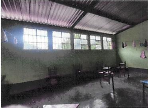
Foto 1: Se necesita reparar las ventanas por lo que se instalarán de pvc
