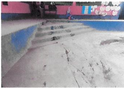
Foto 3: Se instalará piso y fachaleta en el escenario para un mejor ambiente al realizar actos cívicos
